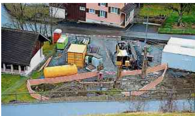
Baustelle mit Startgrube für die Horizontalspülbohrung bei der EW-Zentrale Altendorf (links teilweise sichtbar).
