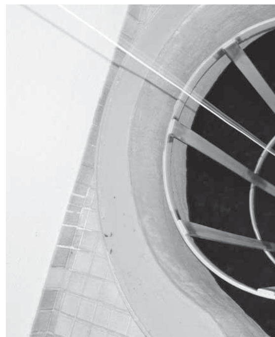
Wasserentnahme im Kraftwerk Tobeläckerli
