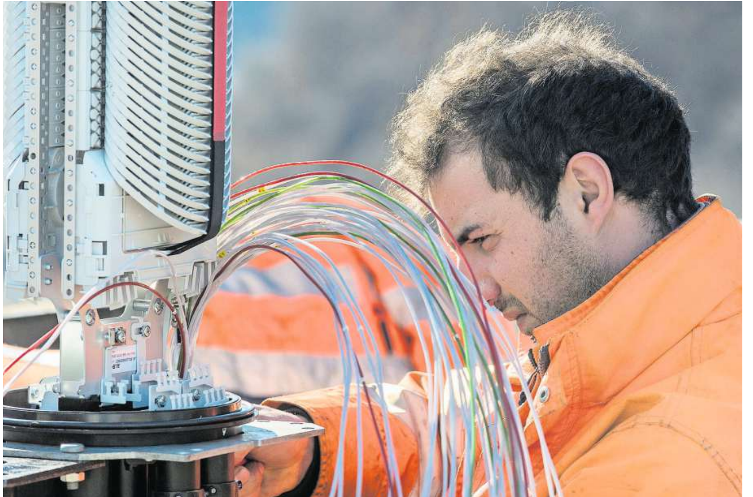
Ein Arbeiter montiert Glasfasern für einen Haushaltanschluss.
